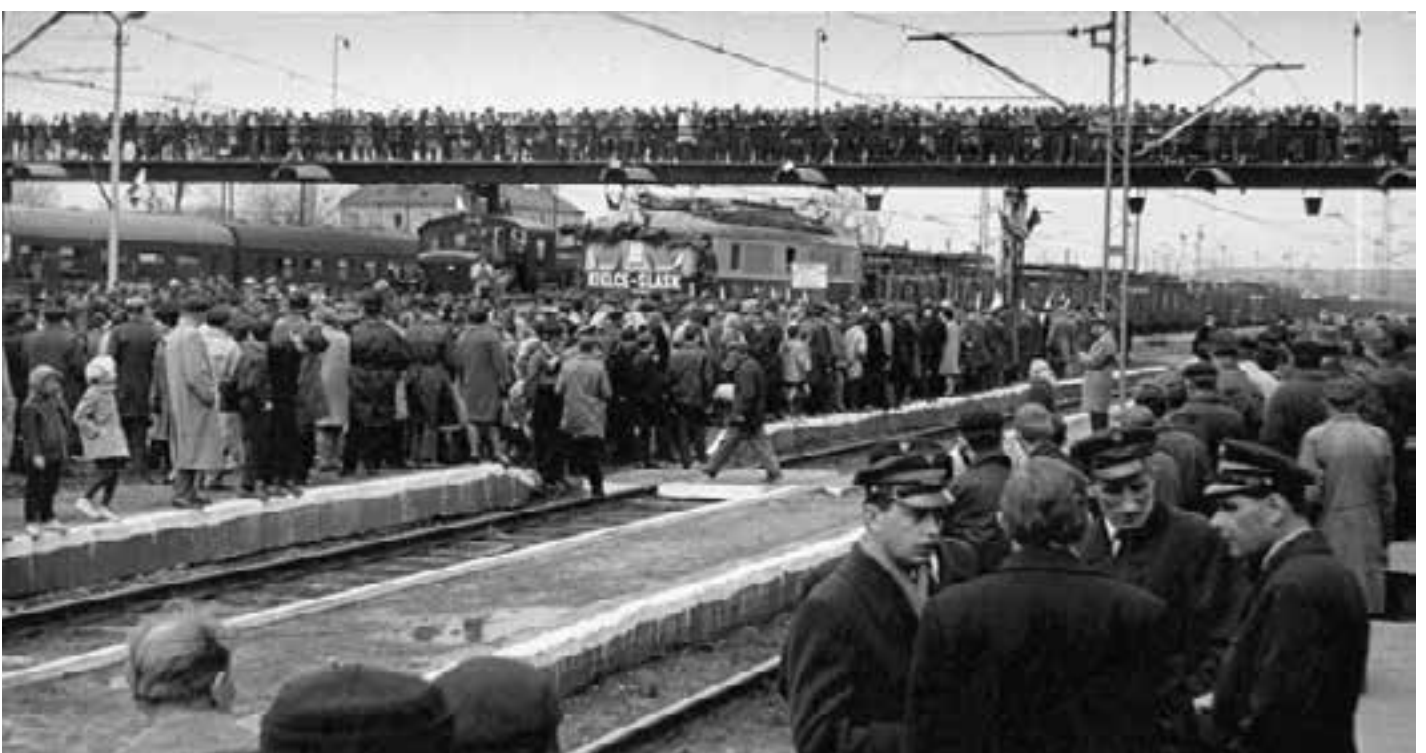
Dawna kładka dla pieszych nad torami dworca
