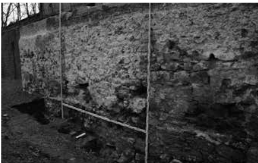
7. Wykop II, profil N
