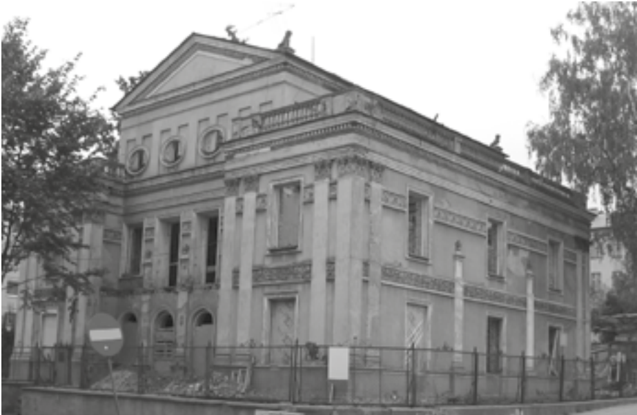
Dawna willa Hütetów, ul. Słowackiego 25, w trakcie remontu w 2011 r.
