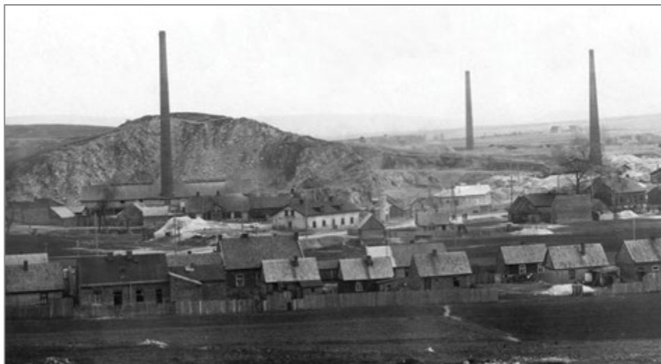
16. Zakład wapienniczy i kamieniołom „Wietrznia” rodziny Zagajskich, widok od północnego-zachodu. Na pierwszym planie dwa wapienniki hoffmanowskie z wysokimi kominami – między nimi widoczny w oddali trzeci komin i fragment szczytu dachu pieca hoffmanowskiego w zakładzie „Międzygórze”, prawdopodobnie lata 30. XX w. Źródło: NAC, sygn. 3/1/0/8/1871.
