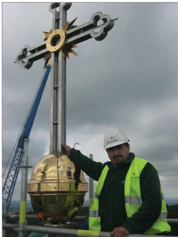
41. Montaż krzyża z rusztowania na hełmie wieży, 2014 r., fot. P. Krzysiek.
