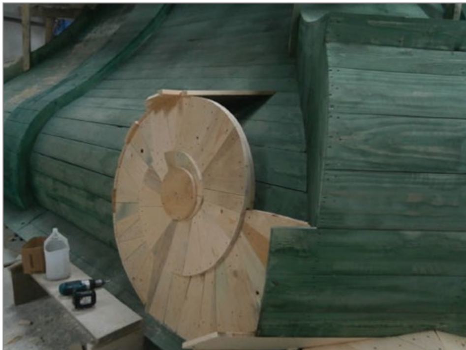
23. Korekta woluty na poszyciu z desek segmentu S1, 2014 r. Źródło: archiwum firmy Burtan – Dachy.
