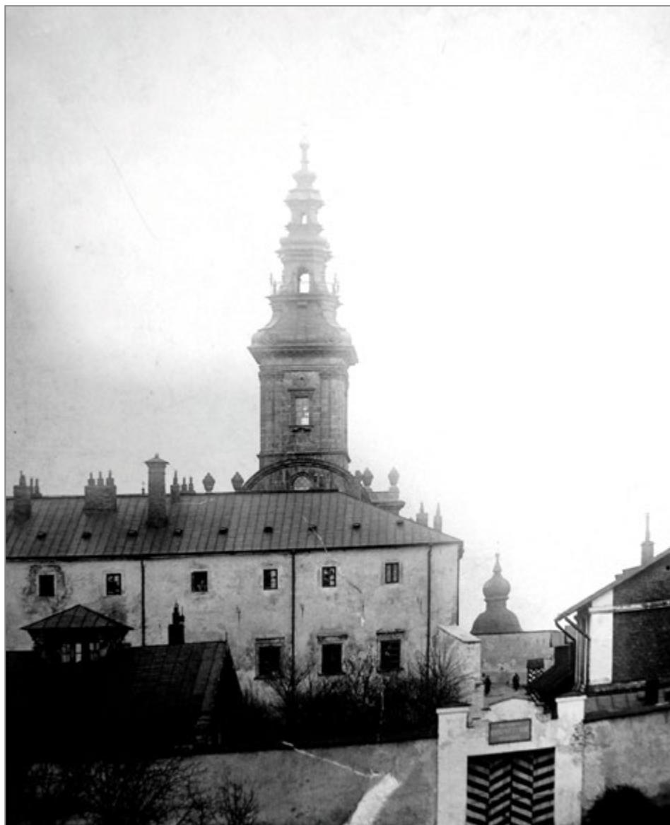
1. Zdjęcie klasztoru od strony więzienia niedługo przed wysadzeniem wieży, 1914 r. Źródło: Archiwum Wojewódzkiego Urzędu Ochrony Zabytków w Kielcach, fot. udostępniona autorowi przez Janusza Cedrę.
