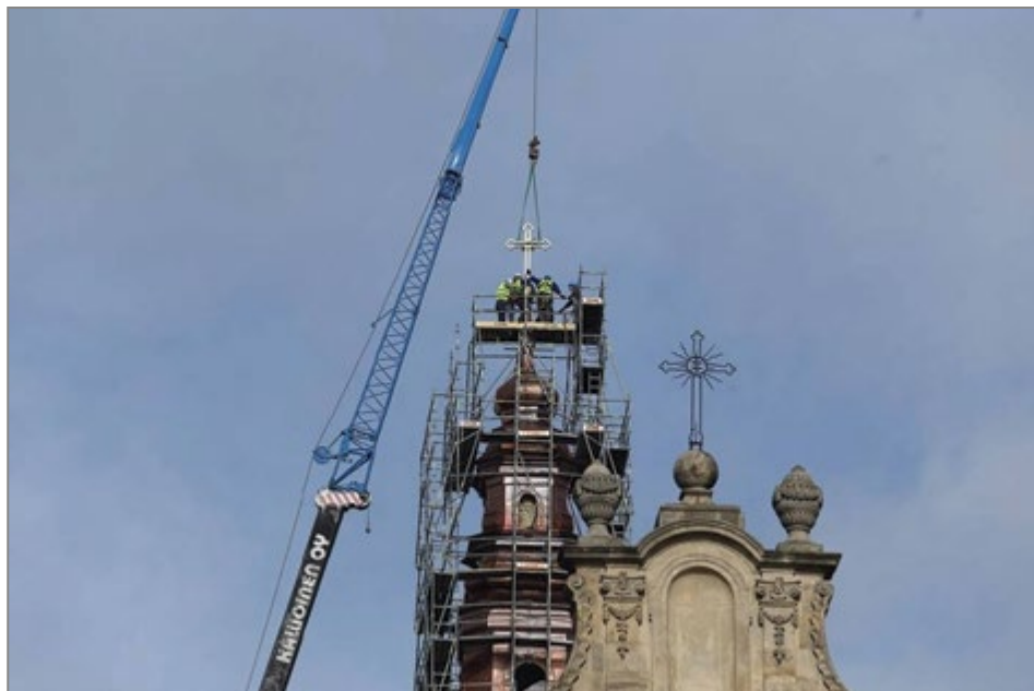
41. Montaż krzyża z rusztowania na hełmie wieży, 2014 r., fot. P. Krzysiek.
