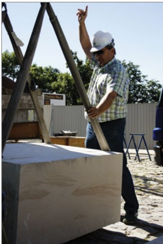
16. Ciosy na placu budowy, widoczne żłobki pod klamry służące do łączenia poszczególnych elementów, 2013 r., fot. R. Jeżowski.
