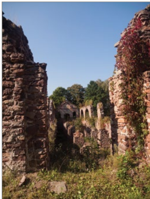
a) stan w 2021 r. (po lewej) – w centrum kadru widoczne dwa łuki konstrukcyjne ściany obwodowej (zbliżenie po prawej). Biokorozja spowodowana przez samosiejki porastające koronę muru skutkuje jego degradacją, fot. P. Wróblewski,
