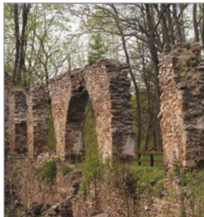
a) stan w 2021 r. (po lewej) – w centrum kadru widoczne dwa łuki konstrukcyjne ściany obwodowej (zbliżenie po prawej). Biokorozja spowodowana przez samosiejki porastające koronę muru skutkuje jego degradacją, fot. P. Wróblewski,
