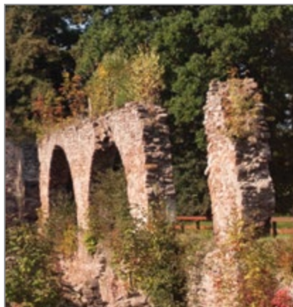
a) stan w 2021 r. (po lewej) – w centrum kadru widoczne dwa łuki konstrukcyjne ściany obwodowej (zbliżenie po prawej). Biokorozja spowodowana przez samosiejki porastające koronę muru skutkuje jego degradacją, fot. P. Wróblewski,
