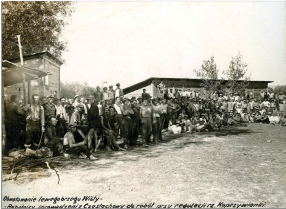
18. Obwałowanie lewego brzegu Wisły, robotnicy pracujący przy regulacji rzeki Koprzywianki, 1933 r. Źródło: MHKi/H/2345.
