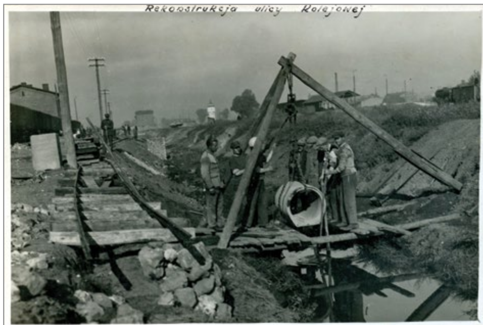
14. Ostrowiec Świętokrzyski, przebudowa ulicy Kolejowej, 1933 r. Źródło: MHKi/H/2345.
