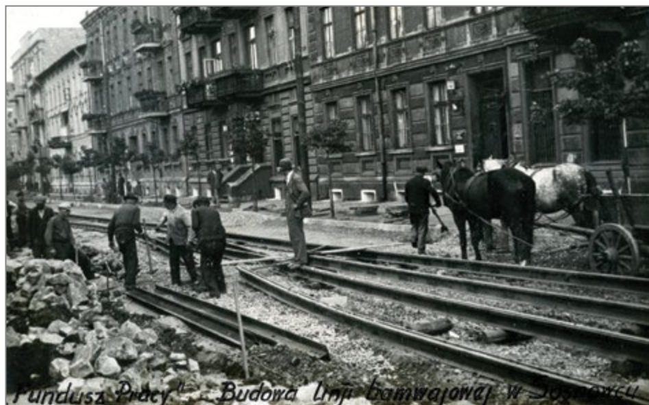
7. Sosnowiec, budowa linii tramwajowej, 1933 r. Źródło: MHKi/H/2345.
