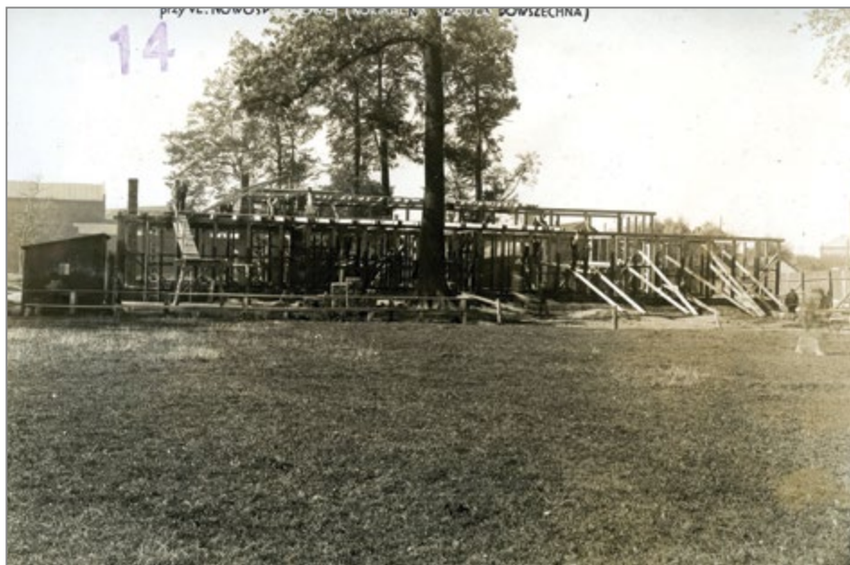
15. Radom, budowa baraku szkolnego, 1933 r. Źródło: MHKi/H/2345.
