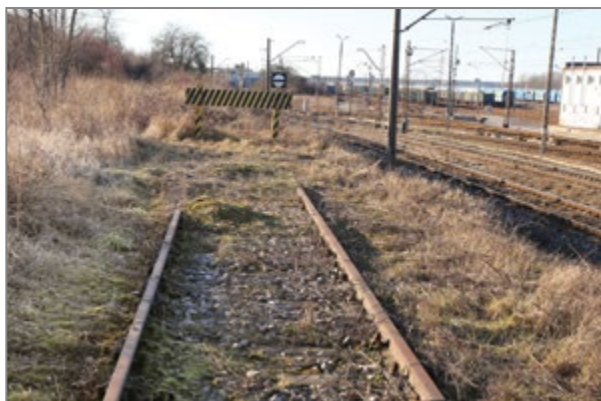
12. Kozioł oporowy bocznic kolejowej, która prowadziła do powojennego zakładu Ślichowice, 2022 r., fot. P. Król.
