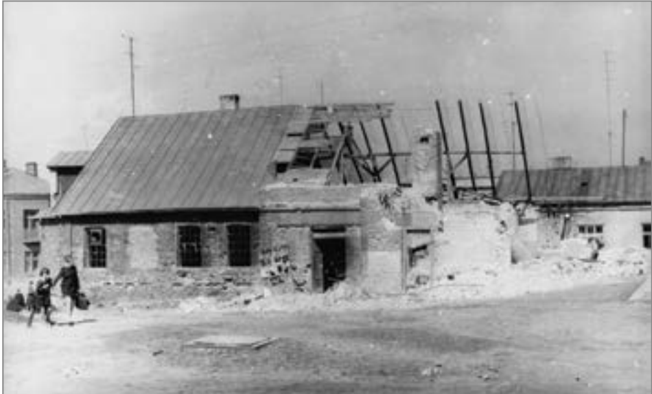
17. Rozbiórka budynku łaźni, 1968 r. Źródło: APK, Zbiór fot., sygn. 159.
