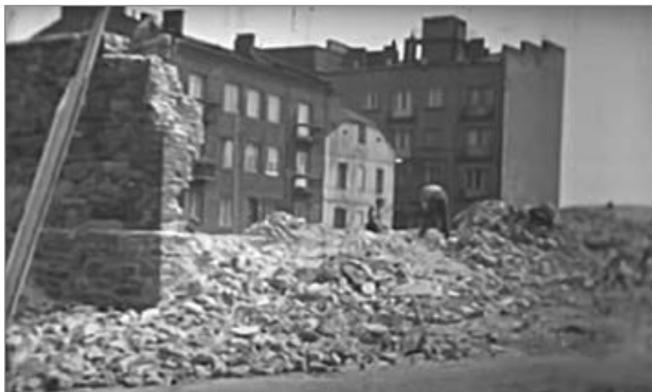
19. Ostatni etap rozbiórki budynku łaźni, 1968 r. Kadr z filmu Wspomnienia na celuloidzie , fot. A. Kurbańskiego. Źródło: zbiory Miejskiej Biblioteki Publicznej w Kielcach.
