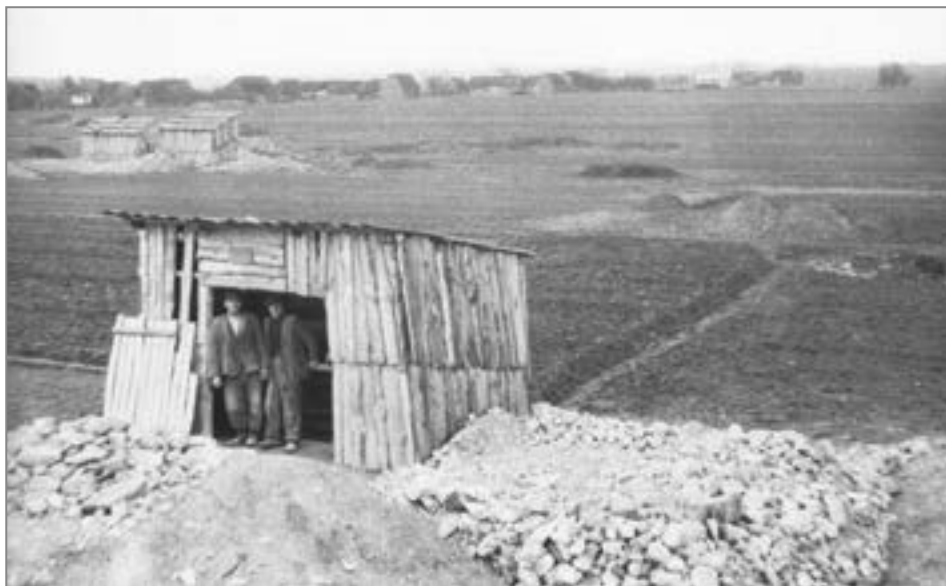
7. Eksploatacja barytu w Strawczyńku w 1954 r. przez Spółdzielnię Pracy „Kopaliny Mineralne” w Kielcach. Sposób wydobycia niewiele się zmienił od tego prowadzonego w okresie międzywojennym. Prymitywne szybiki w polach zabezpieczone prowizorycznie drewnianą obudową, fot. Jerzy Fijałkowski. Źródło: Muzeum Narodowe w Kielcach, MNKi/Pf/425.
