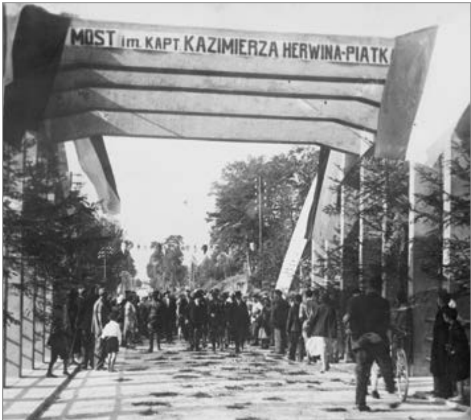
26. Fotografia wykonana prawdopodobnie 8 sierpnia 1931 r., podpisana przez autora: „Most na Słowiku na rzece Bobrzy, dr. państw. nr 13 /trakt Kielce – Kraków/ zbudowany w 1930–1931 r.”, fot. Mieczysław Tuszyński z Kielc [urzędnik kontraktowy w referacie grobownictwa wojennego w Okręgowej Dyrekcji Robót Publicznych UW w Kielcach]. Źródło: zbiory Tomasza Kalety z Zagnańska.
