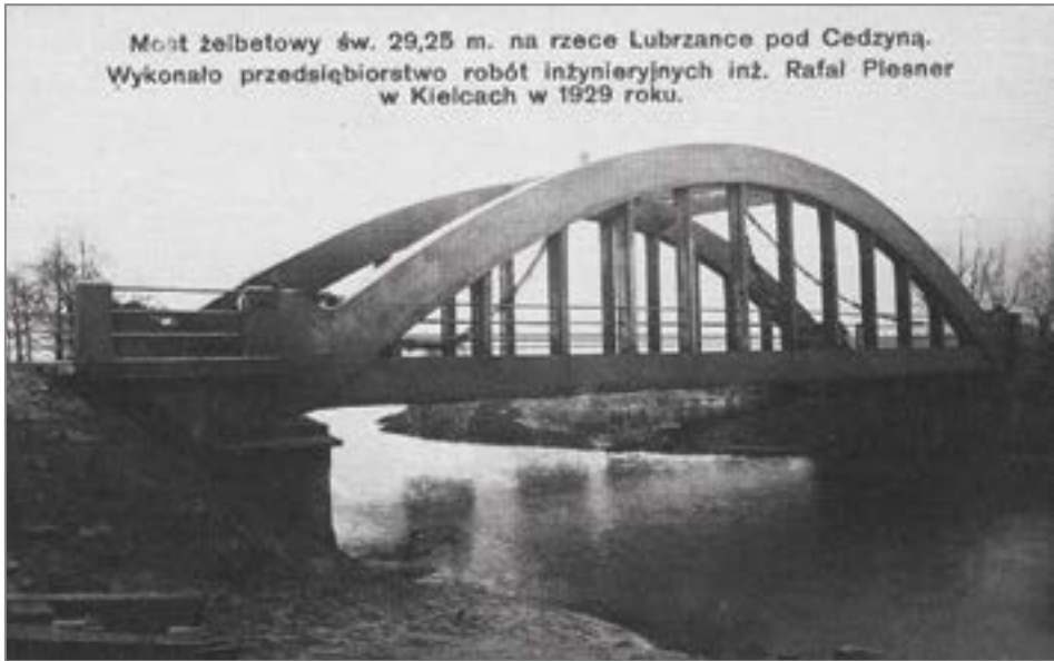
23. Most na rzece Lubrzance w Cedzynie. Napis na fotografii przedstawia prawdopodobnie rok rozpoczęcia budowy mostu, gdyż został on udostępniony do ruchu dopiero 6 września 1930 r. Źródło: T. Wągrowski, Cedzyna i Słowik – dwa mosty i dwie historie , Kielce 2018, s. 7.
