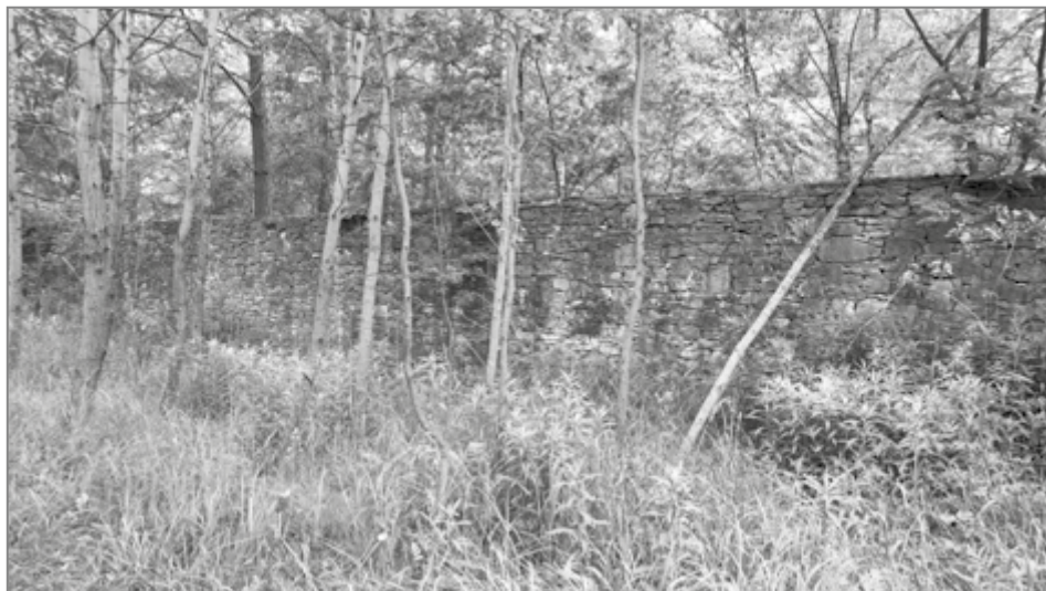
44. Pozostałości kamiennej rampy przeładunkowej zbudowanej przez Spółdzielnię Pracy „Kopaliny Mineralne” w Kielcach, do której doprowadzone były bocznicą kolejowa od stacji PKP w Szarbkowie oraz tory kolejki wąskotorowej z Unikowa (por. il. 42, 43), fot. P. Król, 2025 r.
