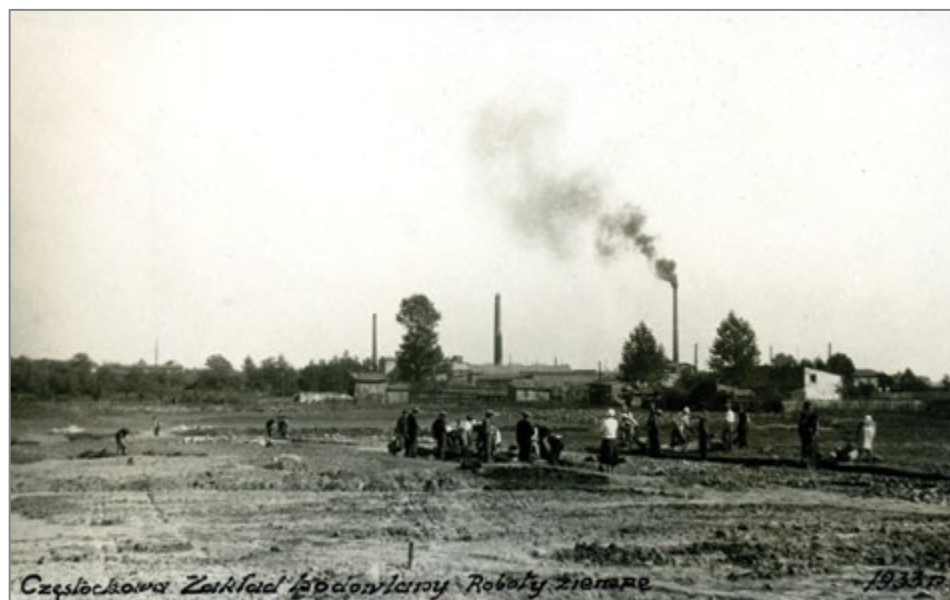
9. Częstochowa, budowa zakładu ogrodniczego przy ul. św. Barbary, 1933 r. Źródło: MHKi/H/2345.
