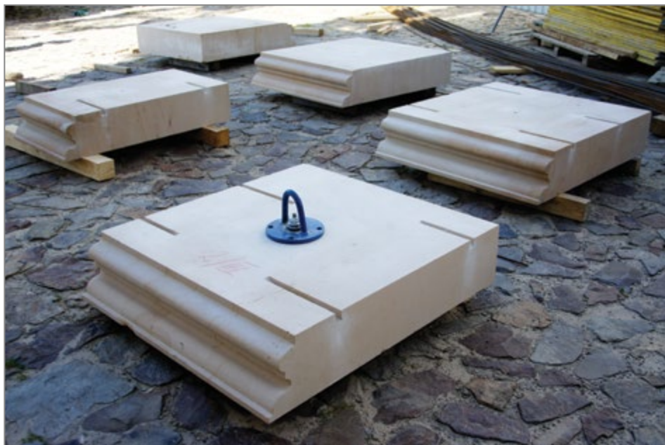
16. Ciosy na placu budowy, widoczne żłobki pod klamry służące do łączenia poszczególnych elementów, 2013 r., fot. R. Jeżowski.
