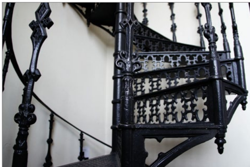
10 a, b. Schody na chór, stan sprzed 2014 r., fot. R. Jeżowski.
