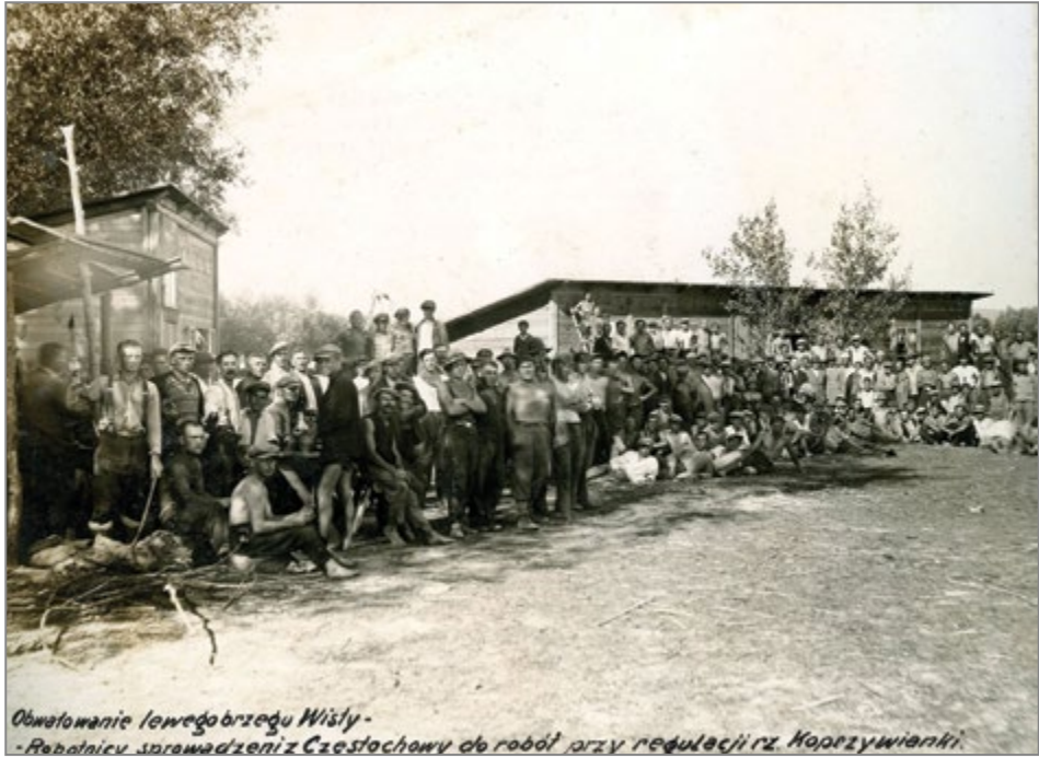
18. Obwałowanie lewego brzegu Wisły, robotnicy pracujący przy regulacji rzeki Koprzywianki, 1933 r. Źródło: MHKi/H/2345.
