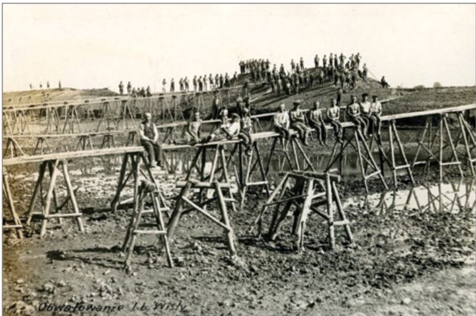
19. Obwałowanie lewego brzegu Wisły, rusztowania przy sypaniu wałów, 1933 r. Źródło: MHKi/H/2345.
