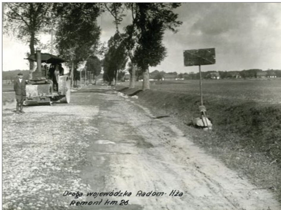
16. Powiat radomski, budowa drogi wojewódzkiej Radom – Iłża, 1933 r. Źródło: MHKi/H/2345.
