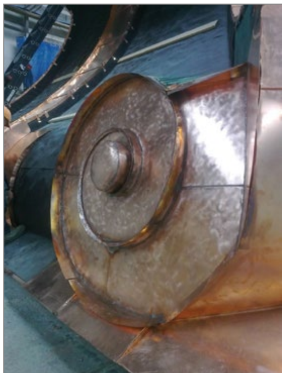
23. Korekta woluty na poszyciu z desek segmentu S1, 2014 r. Źródło: archiwum firmy Burtan – Dachy.
