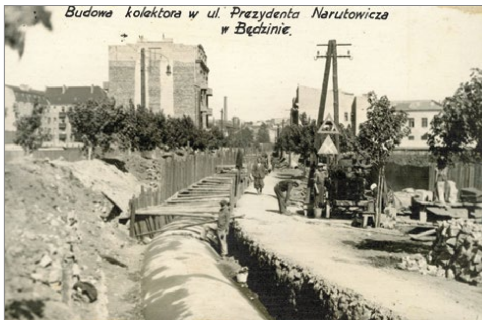
6. Będzin, budowa kolektora w ul. Prezydenta Narutowicza, 1933 r. Źródło: MHKi/H/2345.
