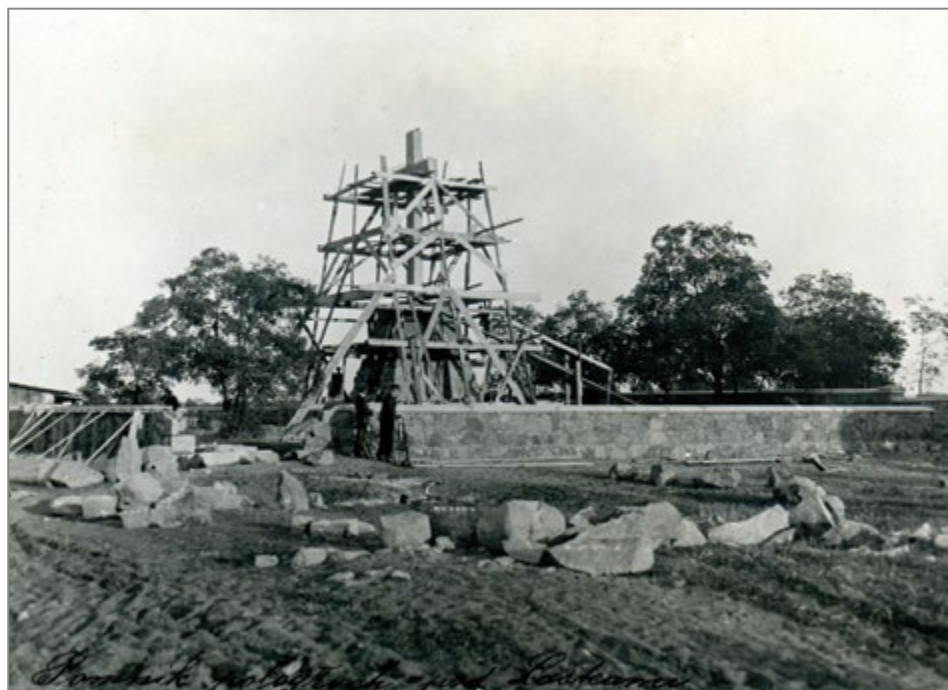
11. Laski, powiat kozienicki, budowa pomnika-mauzoleum poległych legionistów, 1933 r. Źródło: MHKi/H/2345.
