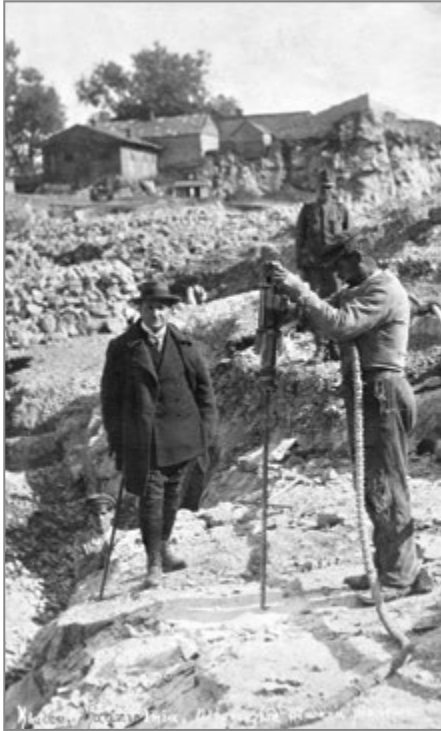
8. Właściciel kamieniołomu „Kadzielnia” Anastazy Ehrlich nadzorujący wiercenie otworu strzelniczego, 1915–1918 r. Źródło: MHKi/H/2031/639.
