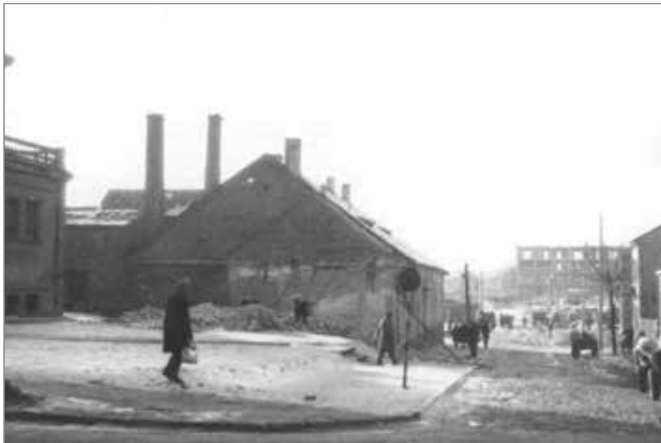
16. Początek rozbiórki budynku łaźni, widok od strony ul. Warszawskiej, w oddali rozpoczęta budowa gmachu Urzędu Wojewódzkiego, 1968 r. Źródło: zbiory autora.
