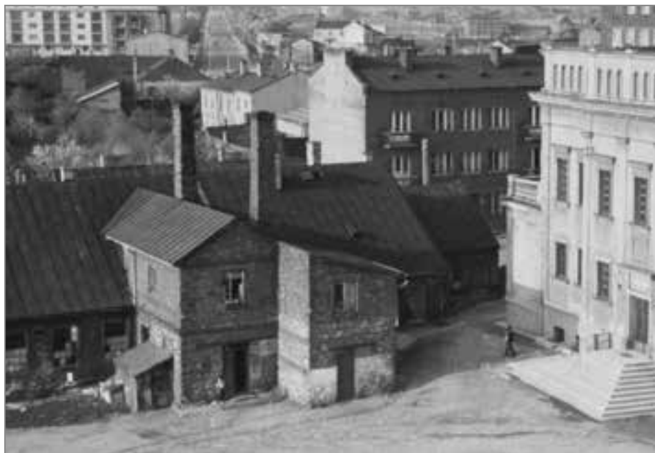
14. Opuszczony budynek łaźni, 1966–1968, Źródło: MHKi_I_4763.
