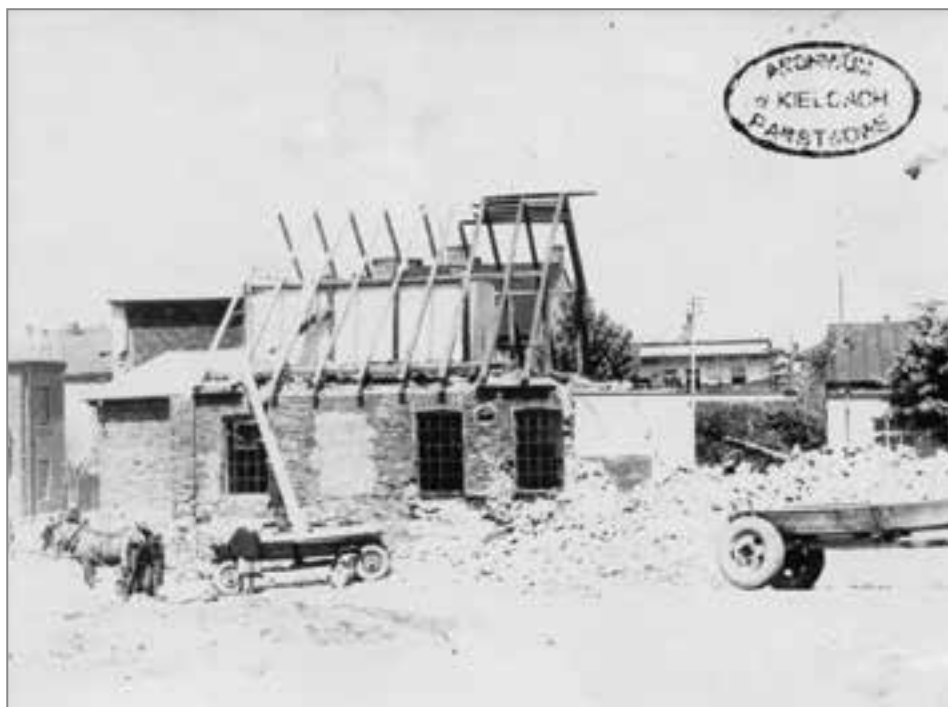
18. Rozbiórka budynku łaźni, 1968 r. Źródło: APK, Zbiór fot., sygn. 117.
