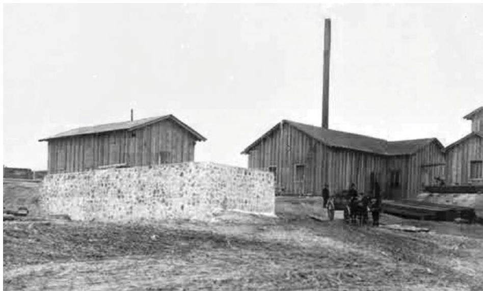
Il. 6. Widok zabudowań szybu „Barbara” od południowego wschodu, 1916 r.; Archiwum Państwowe w Wiedniu, AT-OeStA/KA BS I WK Fronten Polen, Niewachlow, Kreis Kielce, 2423
