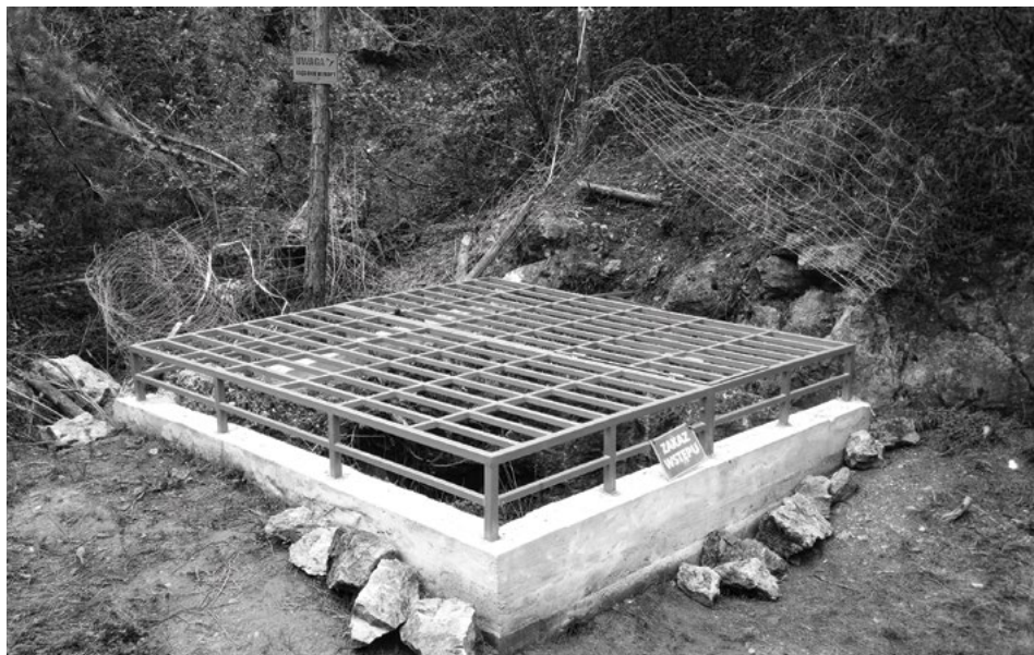
Il. 14. Aktualne zabezpieczenie wejścia do sztolni „Teresa”, fot. T. Wróblewski
