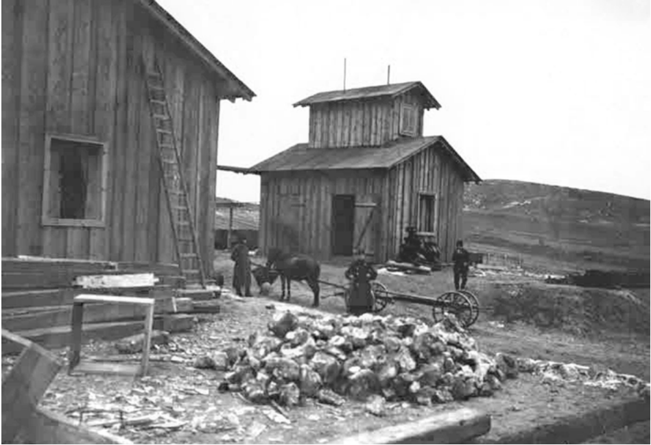
Il. 8. Widok zabudowań szybu „Barbara” od południowego zachodu, 1916 r.; Archiwum Państwowe w Wiedniu, AT-OeStA/KA BS I WK Fronten Polen, Niewachlow, Kreis Kielce, 2398
