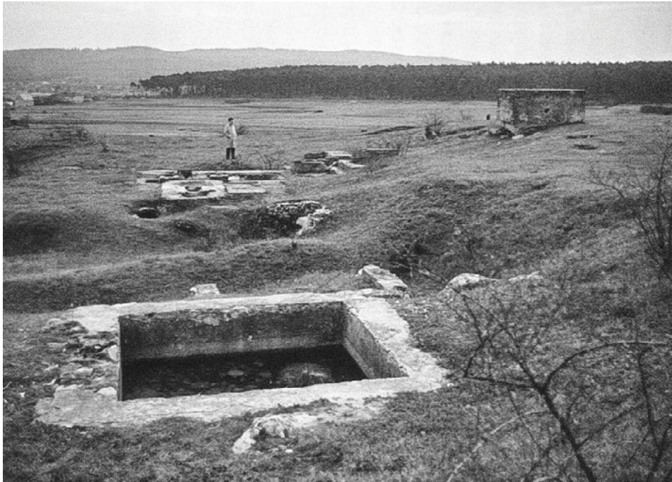
Il. 12. Betonowe pozostałości infrastruktury technicznej szybu „Barbara”, na pierwszym planie zbiornik na wodę, widok od północy, 1968 r., fot. Tymoteusz Wróblewski, źródło: T. Wróblewski, Śladami dewońskiego morza i kieleckich gwarków, UM Kielce, 2012, s. 43
