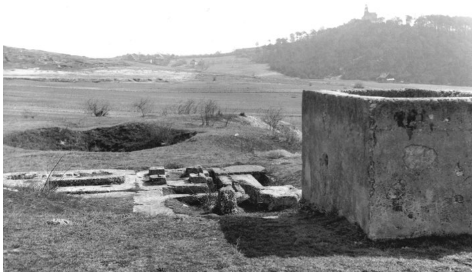
Il. 11. Betonowe pozostałości infrastruktury technicznej szybu „Barbara”, na pierwszym planie zbiornik na wodę, widok od zachodu, 1965 r., fot. Jerzy Fijałkowski; Muzeum Narodowe w Kielcach, Dział Historii Naturalnej, MNKi/Pf/1271
