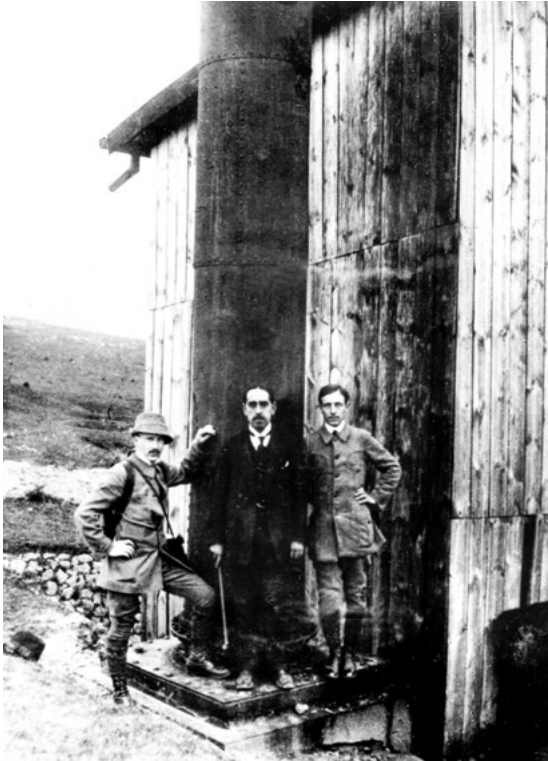
Il. 4. Zdjęcie przedstawiające (od lewej) Jana Czarnockiego, osobę nieznaną i Jana Samsonowicza przy budynku kotłowni szybu „Barbara”, Muzeum Narodowe w Kielcach, Dział Historii Naturalnej MNKi/Ph/5
