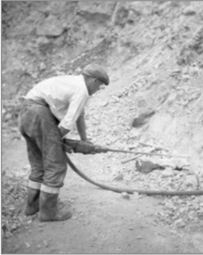
f – wiercenie otworów strzałowych, fot. J. Fijałkowski, 1957 r.; źródło: MNKi/Pf/817,
