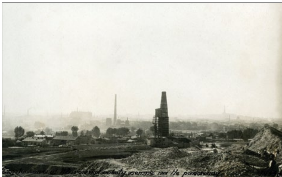
10. Częstochowa, budowa ul. Mirowskiej, 1933 r. Źródło: MHKi/H/2345.
