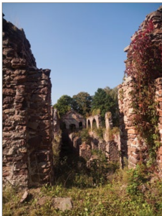
a) stan w 2021 r. (po lewej) – w centrum kadru widoczne dwa łuki konstrukcyjne ścian obwodowej (zbliżenie po prawej). Biokorozja spowodowana przez samosiejki porastające koronę muru skutkuje jego degradacją, fot. P. Wróblewski,
