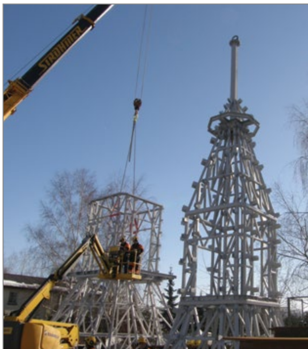
20. Próbnny montaż konstrukcji stalowej hełmu, 2014 r. Źródło: archiwum spółki Furmanek Renewal.
