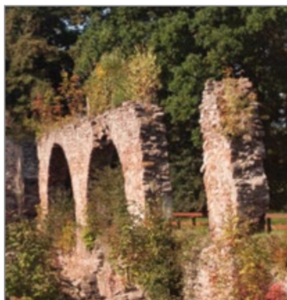
a) stan w 2021 r. (po lewej) – w centrum kadru widoczne dwa łuki konstrukcyjne ścian obwodowej (zbliżenie po prawej). Biokorozja spowodowana przez samosiejki porastające koronę muru skutkuje jego degradacją, fot. P. Wróblewski,
