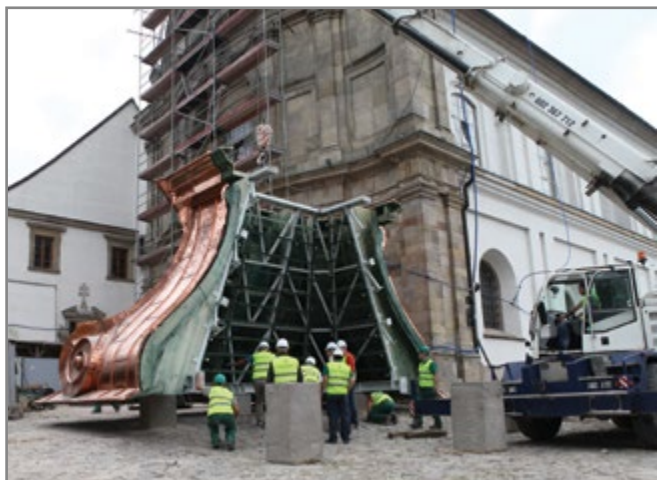
32. Przygotowanie połowy segmentu S1 do połączenia w całość z drugą połową, 2014 r. Źródło: archiwum spółki Furmanek Renewal.
