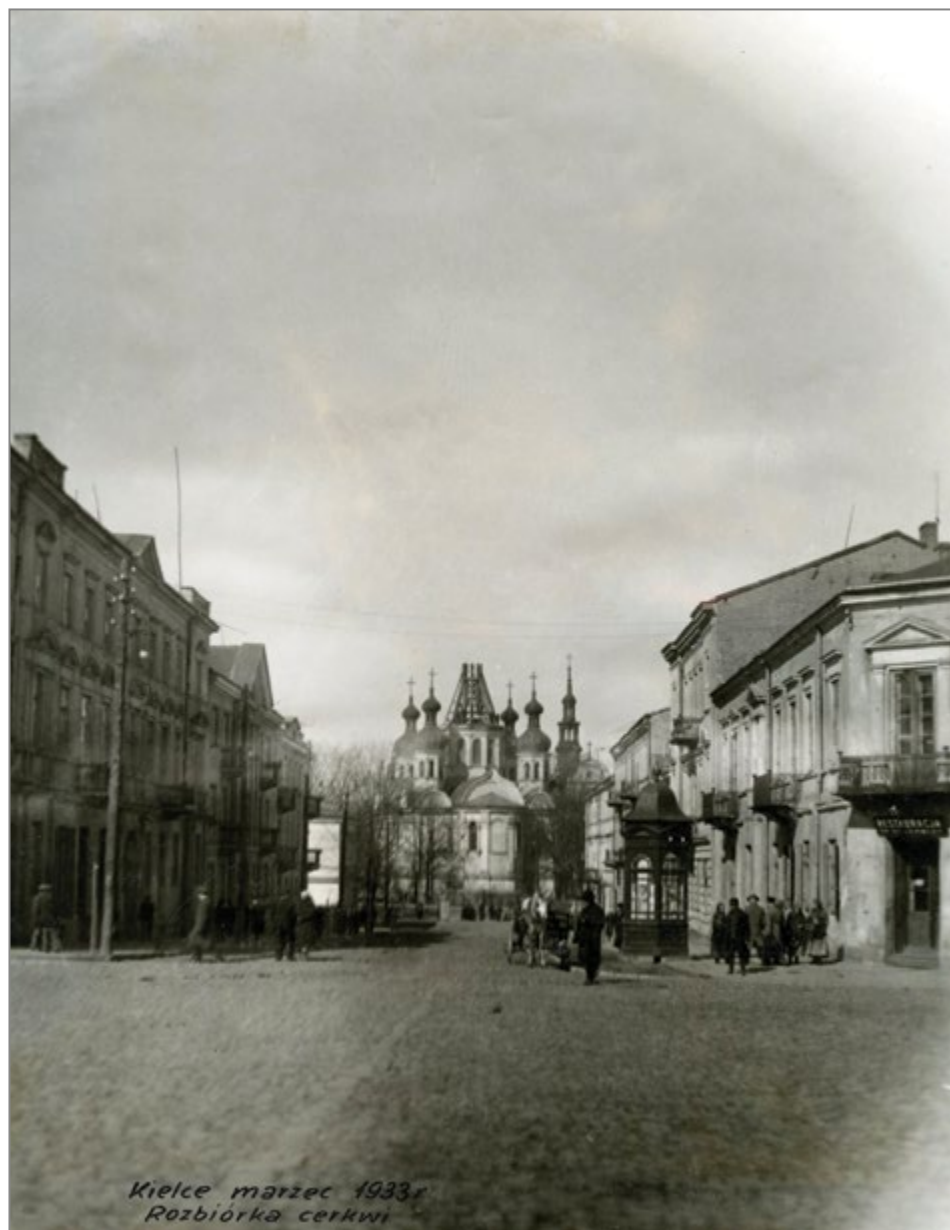
3. Kielce, rozbiórka cerkwi pw. Wniebowstąpienia Pańskiego, 1933 r. Źródło: MHKi/H/2345.
