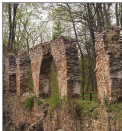
a) stan w 2021 r. (po lewej) – w centrum kadru widoczne dwa łuki konstrukcyjne ścian obwodowej (zbliżenie po prawej). Biokorozja spowodowana przez samosiejki porastające koronę muru skutkuje jego degradacją, fot. P. Wróblewski,
