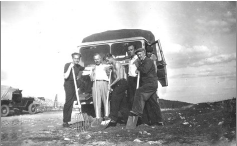
h – pierwszy samochód zakupiony w Spółdzielni „Kopaliny Mineralne”, w czynnie społecznym brygada dokonuje reperacji dróg dojazdowych, ok. 1955 r.; źródło: Księga pamiątkowa Spółdzielni Pracy „Kopaliny Mineralne” w Kielcach, s. 14.
