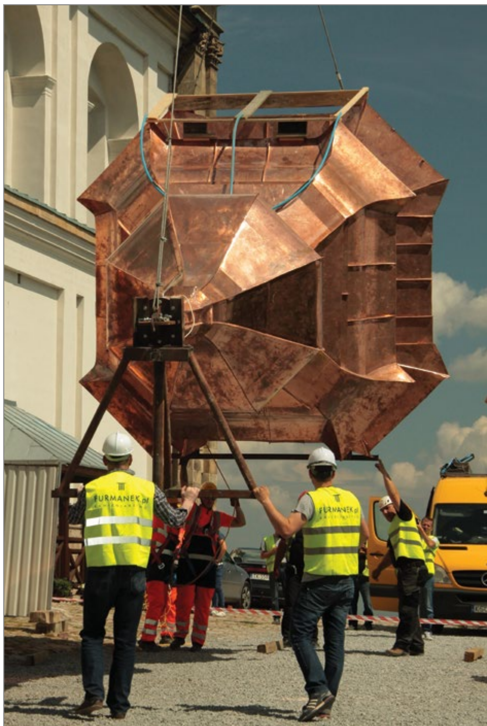
36. Przygotowanie segmentu S4 do podnoszenia, 2014 r. Źródło: archiwum spółki Furmanek Renewal.
