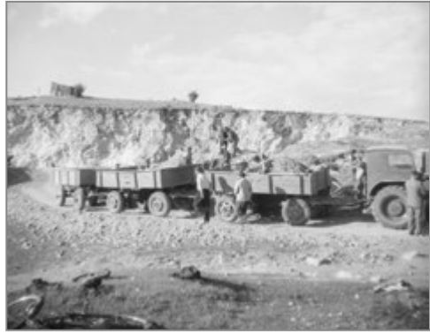
c – załadunek urobku na przyczepy ciągnikowe, fot. J. Fijałkowski, 1957 r.; źródło: MNKi/Pf/710,
