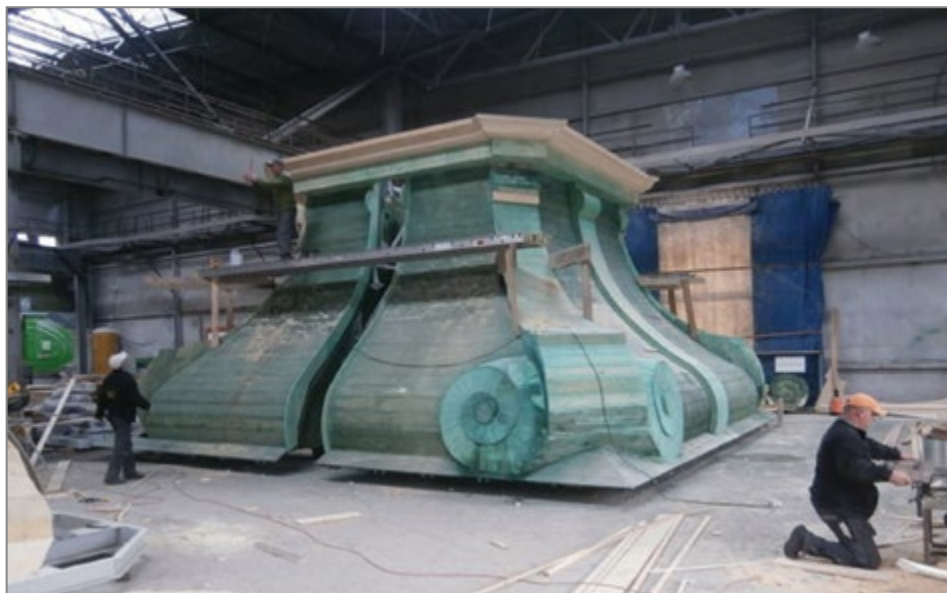
25. Poszycie z desek segmentu S1, 2014 r. Źródło: archiwum firmy Burtan – Dachy.
