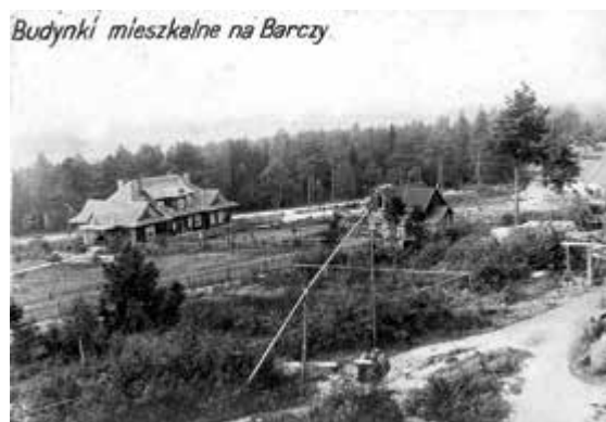
Il. 13. Zabudowania na zachodnim stoku Barczy, po lewej stronie drewniany dom Zarządu Państwowych Kamieniołomów w Zagnańsku zbudowany ok. 1925 r. (istniejący do dziś – il. 14), z prawej strony widoczny fragment baraku dla robotników; zdjęcie wykonane w latach 1932–33 r., pochodzi z albumu dokumentującego prace finansowane przez Fundusz Pracy, Muzeum Historii Kielc, nr inw. MHKi/H/2345
