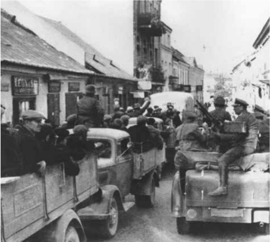
Il. 19. Transport ludności do prac przy budowie niemieckich umocnień wokół Kielc, 28 września 1944 r., Muzeum Historii Kielc, nr inw. MHKi/H/1624
