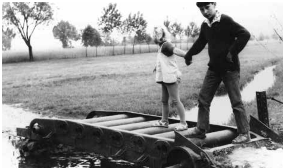
Il. 5. Element zawieszenia niemieckiego półgąsienicowego transportera opancerzonego Sd.Kfz. 251 w charakterze mostka w miejscowości Chałupki Zbrzańskie (gmina Morawica); Album rodzinny..., t. XV, 1968, nr inw. I-47
