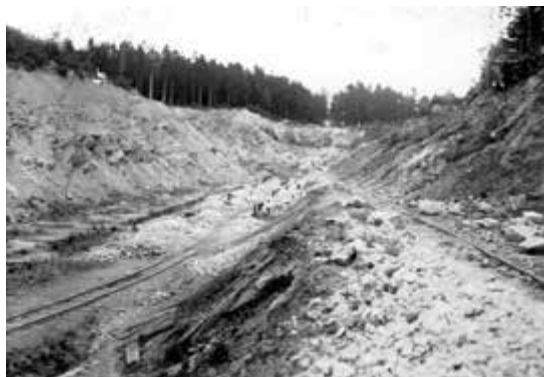
Il. 8. Wyrobisko „Kopalni Starej” widoczne od strony zachodniej; tamże
