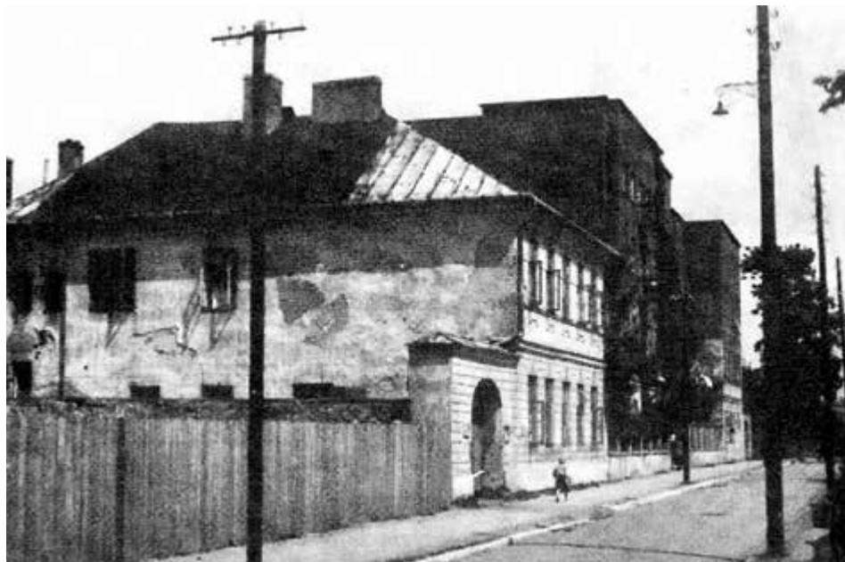
Il. 4. Budynek główny szpitala św. Aleksandra po przebudowie, po 1945 r.; ze zbiorów prof. S. Koby
