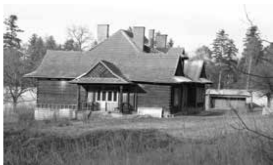
Il. 14. Drewniany dom Zarządu Państwowych Kamieniołomów w Zagnańsku zbudowany ok. 1925 r., zamieszkały obecnie przez Włodzimierza Jabłońskiego, syna ostatniego kierownika kamieniołomów barczańskich Jana Jabłońskiego, fot. P. Król, 2019 r.
