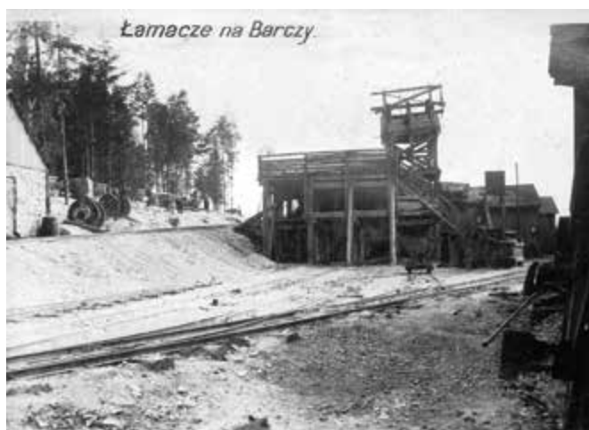
Il. 6. Zabudowania gospodarcze oraz drewniana konstrukcja kruszarek; tamże
