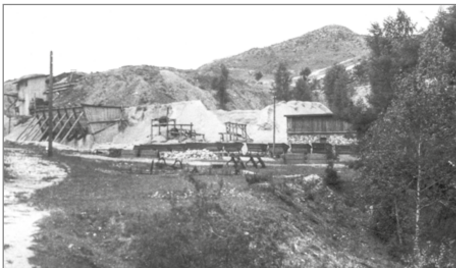
Il. 8. Fotografia zakładu w Miedziance z 1937 r., który dzierżawiony był razem z pobliskim kamieniołomem „Ołowianka” przez zakład „Sitkówka”; po stronie lewej zdjęcia widoczna jest kruszarka i zasobnik gysu; zdjęcie z kolekcji Anny Kulińskiej
