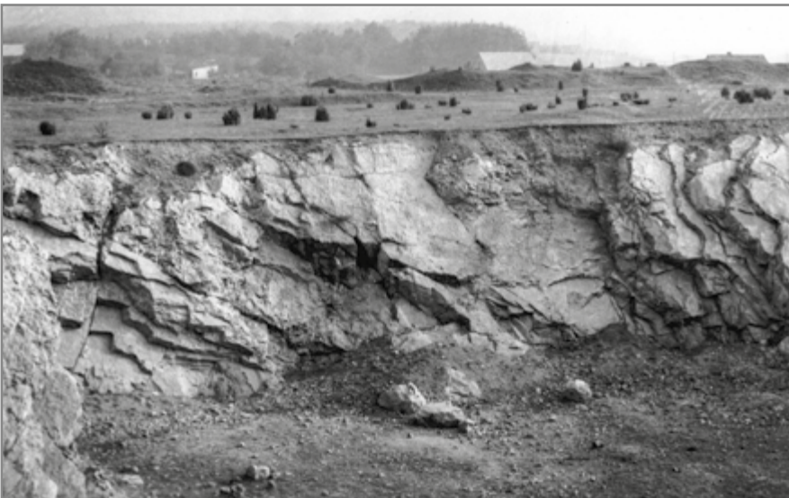
Il. 21. Zakład „Kostrzewa”. Nieistniejąca obecnie północna ściana kamieniołomu, fot. J. Fijałkowski, 1966 r.; zbiory Muzeum Narodowego w Kielcach, MNKi/Pf/1541
