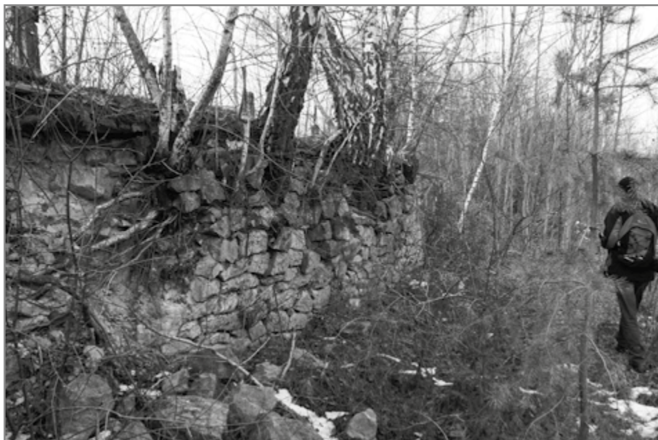
Il. 13. Zakład „Sitkówka”, pozostałości rampy kolejowej zbudowanej w latach 1922–1928 r.; fot. P. Król, 2019 r.
