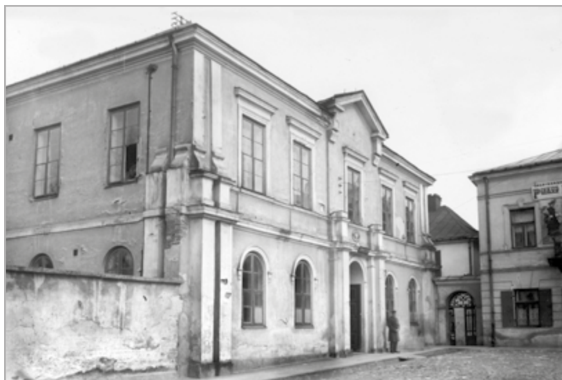
Il. 11. Budynek dawnego gimnazjum żeńskiego przy ul. Leśnej; Archiwum Świętokrzyskiego Wojewódzkiego Konserwatora Zabytków w Kielcach
