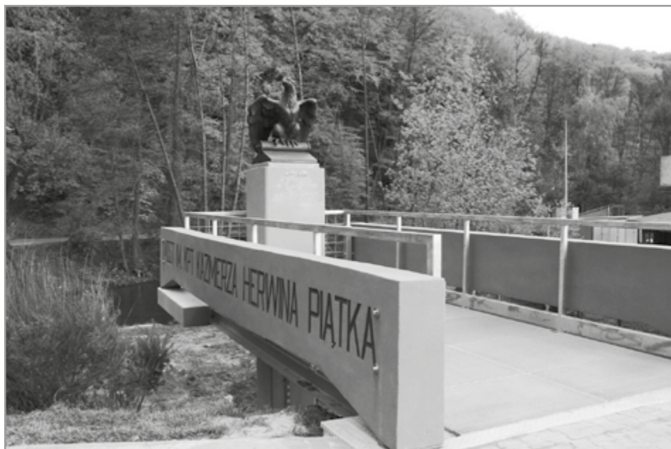
10. Platforma widokowa, widok od strony Chęcín, 7.06.2017
