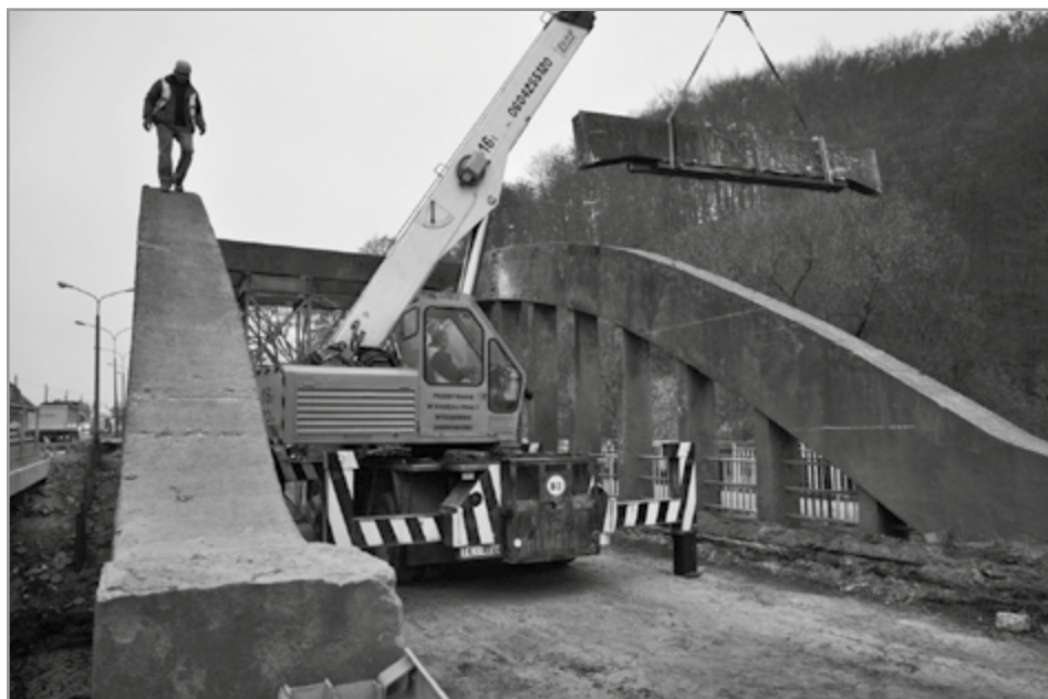
5. Demontaż tężników od strony Kielc, 15.11.2011 r.
