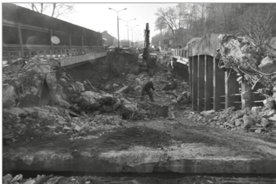
7. Prace rozbiórcze mostu przy użyciu specjalistycznego sprzętu, 29.11.2011 r.
