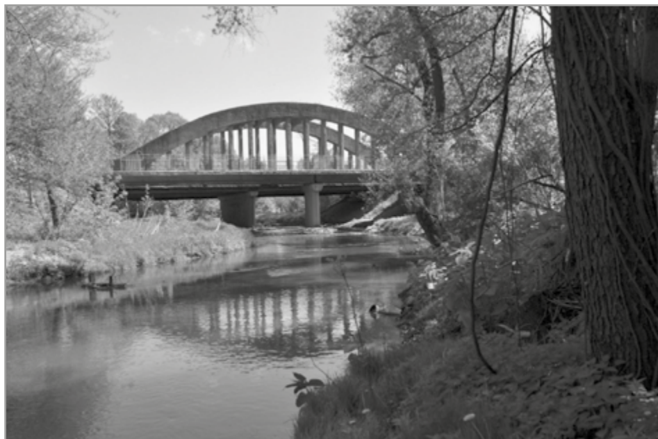
2. Rzeką Bobrza, widok na most od strony ulicy Zalesie; widoczne podpory są elementami kładki i mostu na lewej jezdni drogi 762; 2.08.2011 r.
