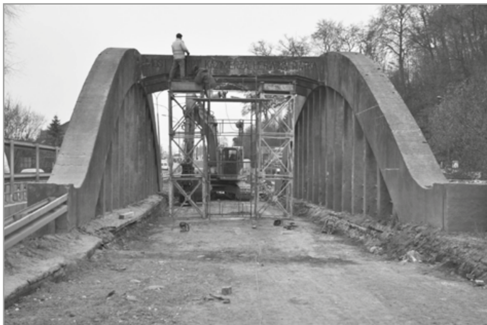
4. Przygotowanie do wycinania tężnika, 15.11.2011 r.
