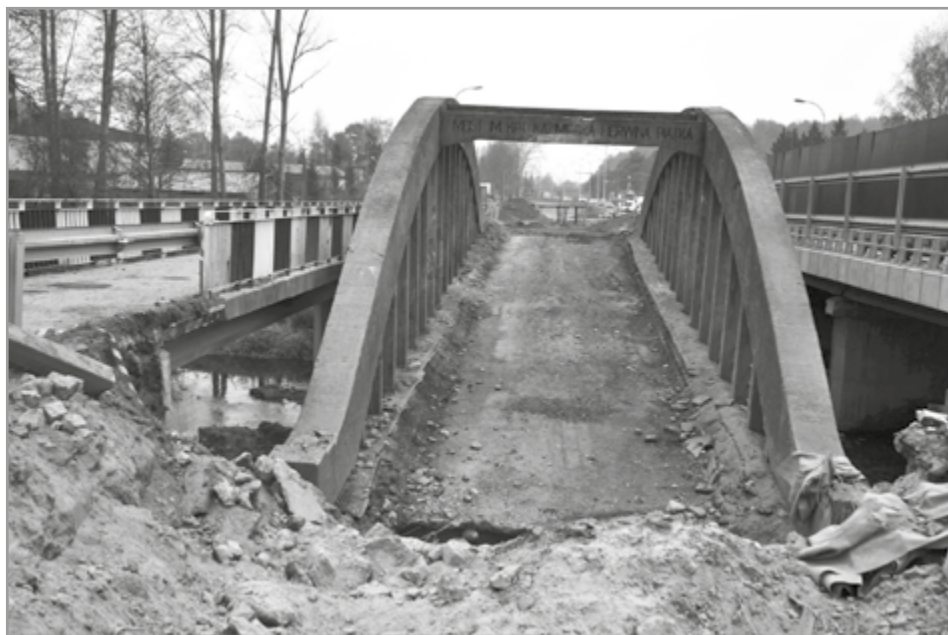
6. Przeszło po wysadzeniu przyczółka mostu, 21.11.2011 r.
