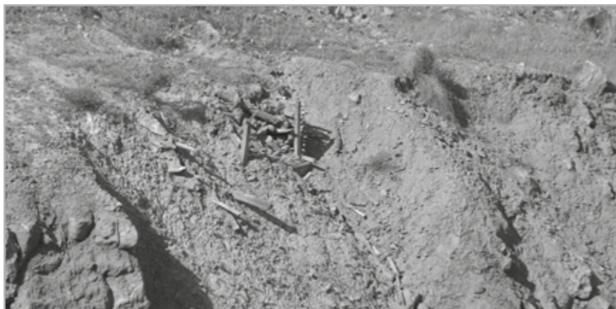
Ryc. 10. Drewniana obudowa chodnika rozpoznawczego z okresu prac górniczych prowadzonych na początku XIX w. i podczas I wojny światowej, odsłaniające się w północno-zachodniej ścianie kamieniołomu „Laskowa”; fot. Paweł Król, 2006 r.
