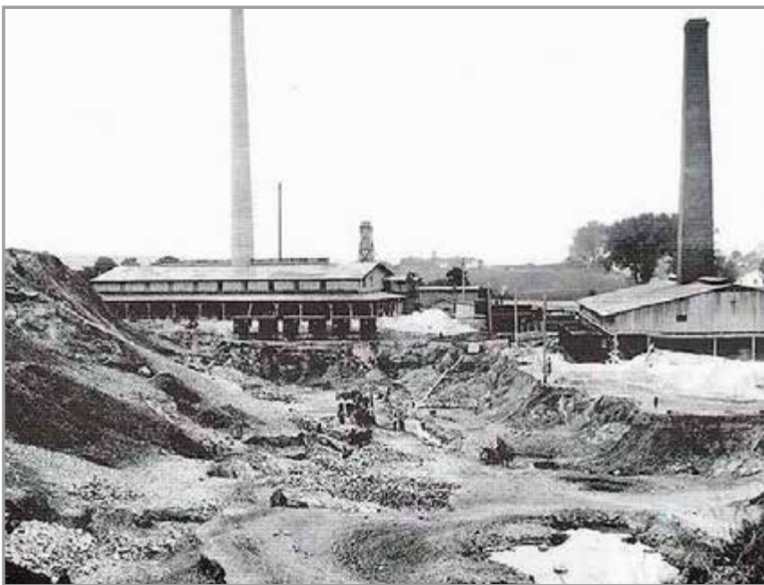
Wapienniki na Kadzielni; fot. z archiwum autorów
