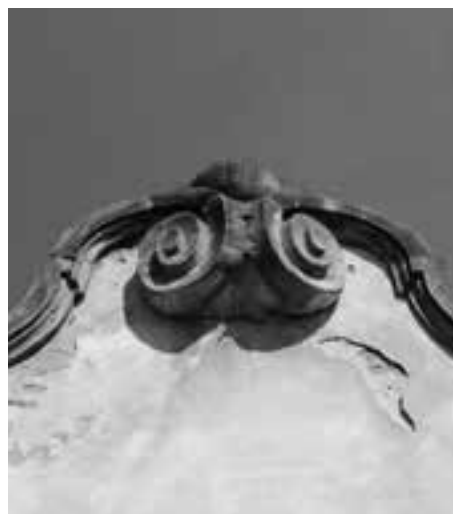
3. Łaźnia – zwieńczenie elewacji nad wejściem; fot. K. Myśliński 2009 r.
